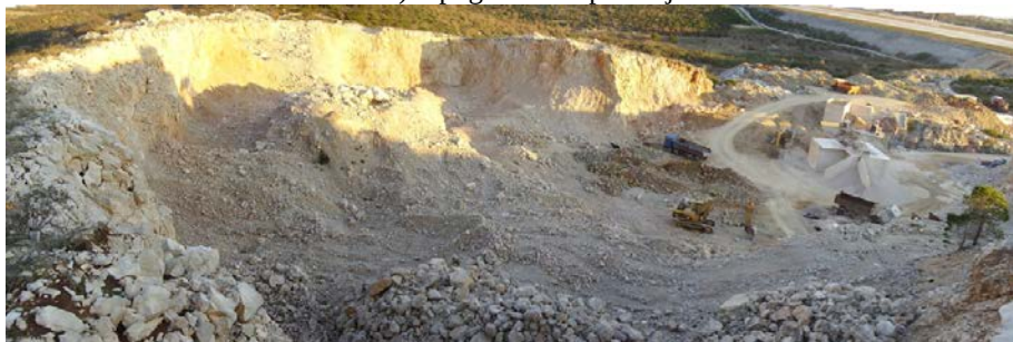
b) pogled na kop u smjeru JJ
